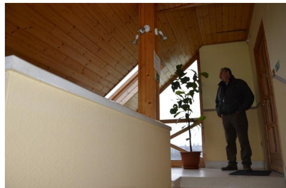
Tetőtéri előtér, pihenő
