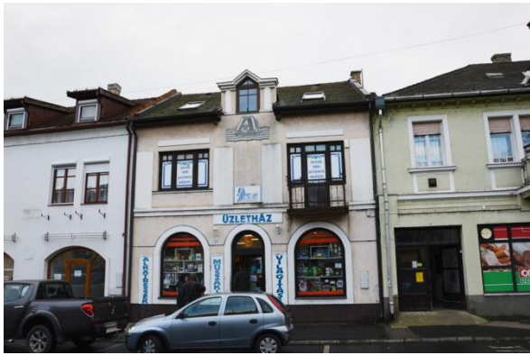
Kossuth utcai homlokzat
